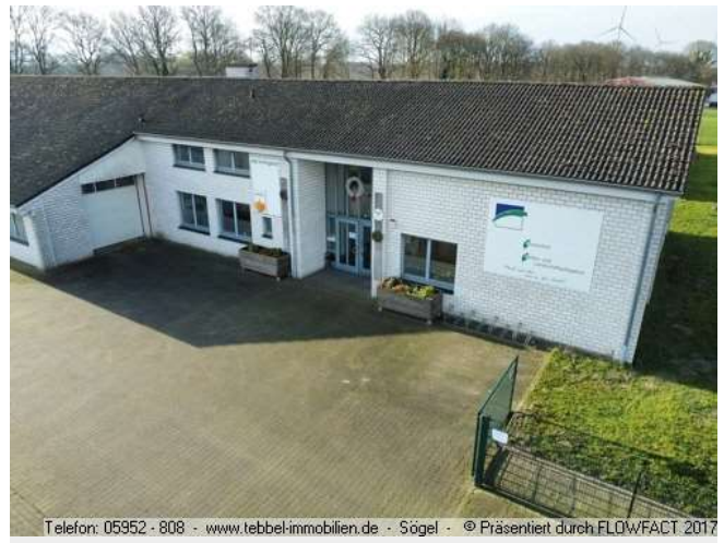
Ansicht - Eingang - Büro - Schulung
