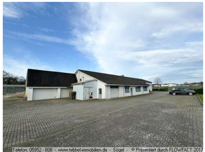
Ansicht vom Parkplatz
