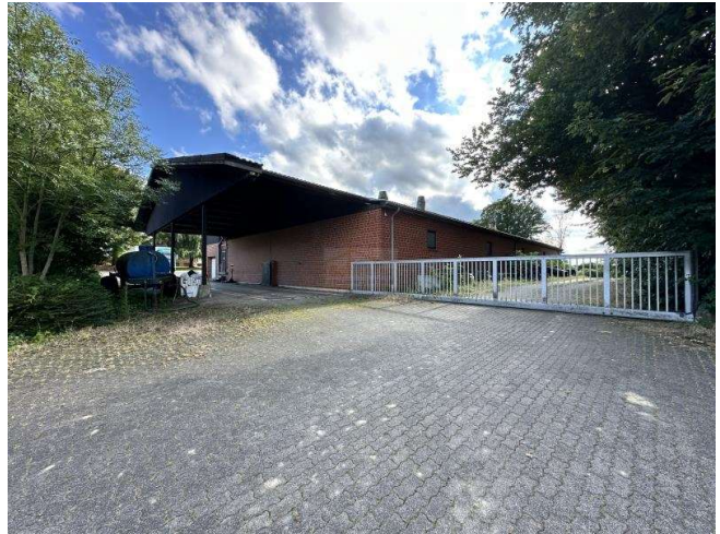
Waage mit Überdach
